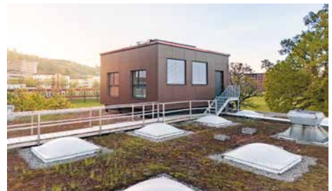
Im Forschungsmodul lassen sich verschiedene gebäudetechnische Systeme und Innovationen realitätsnah testen. Foto: HSLU
