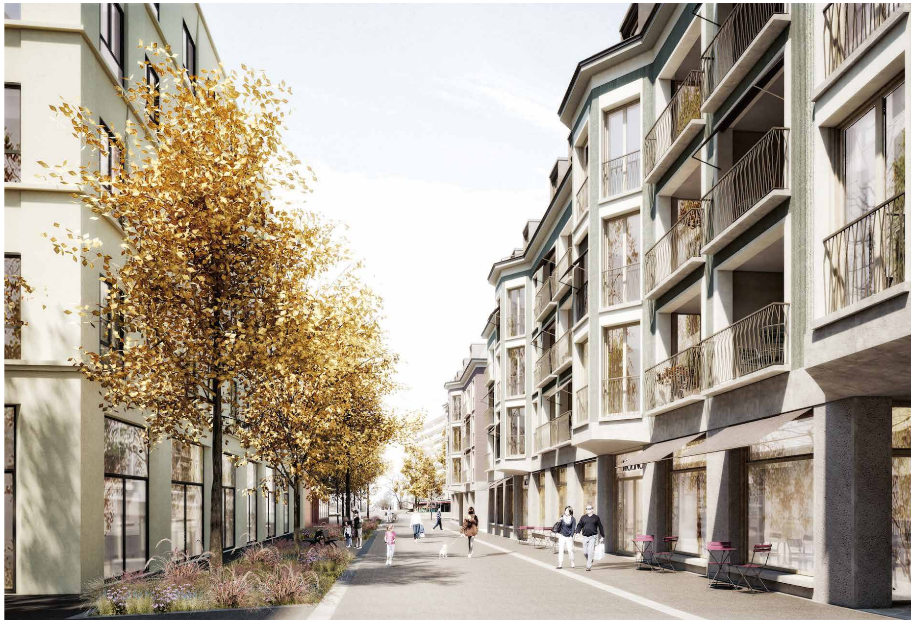
Aufwendig gestaltete Fassaden erfordern von den ausführenden Handwerkern höchste Präzision. Visualisierung: Raumfindung Architekten
